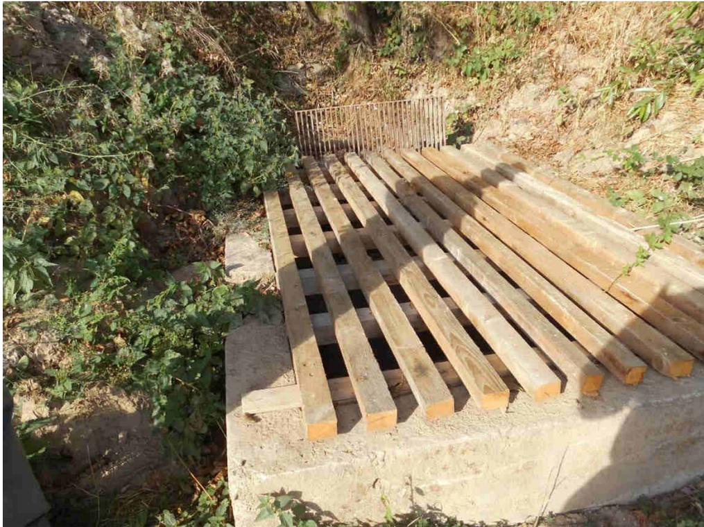
**Abbildung: Provisorischer Rechen am Ohrenstaller Graben**
