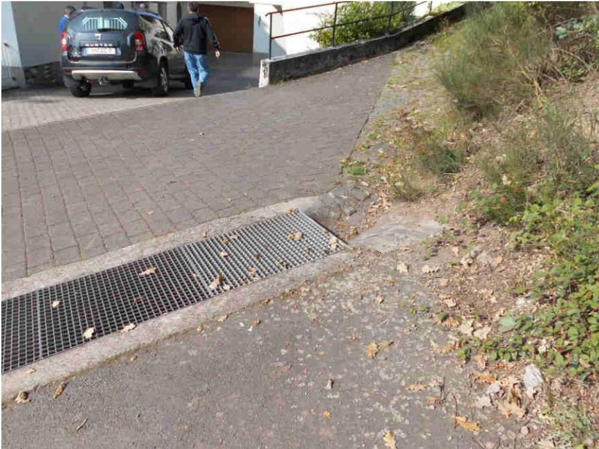
**Abbildung: Geröllfang mit Gitterrosten**
