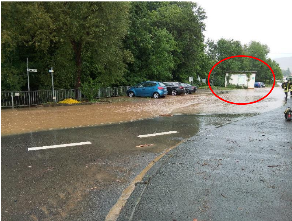
Abbildung 10 Trafostation in der Soonwaldstraße (Hochwasser am 29/30.05.2016)
