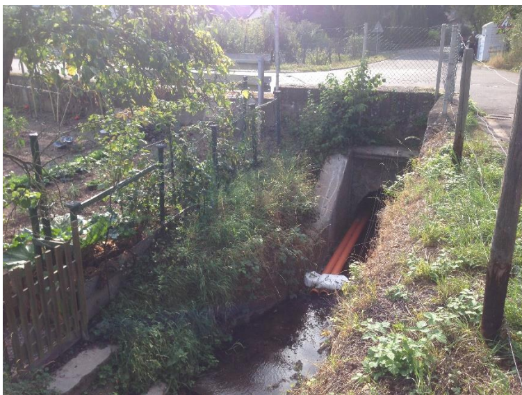
Abbildung 7 Neubau des Rechen an der Kirbachverrohrung
