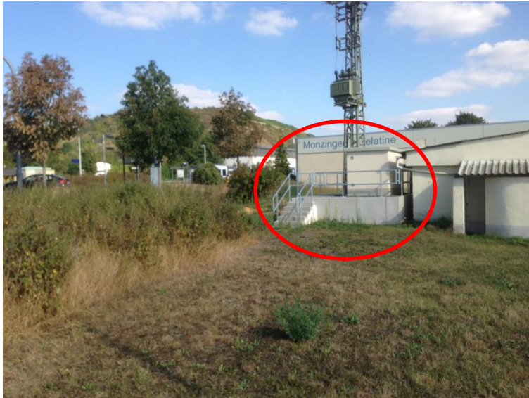
Abbildung 5 Hochwassergeschützte Trafostation
