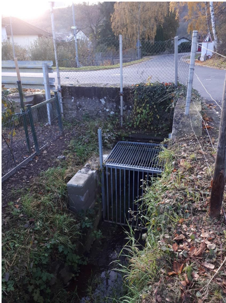
Abbildung 3 Beginn der Kirbachverrohrung 2019
