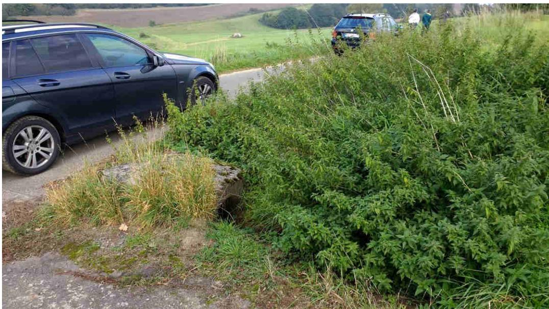
**Abbildung: Zugewachsener Einlauf; Herrnwasem**
