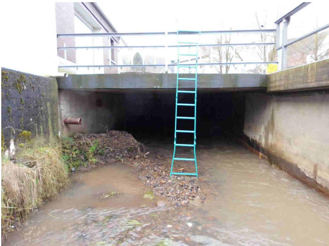
**Abbildung: Rahmenprofil K 67, Auslauf**
