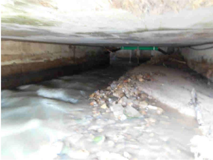
**Abbildung: Ablagerungen Rahmenprofil**
