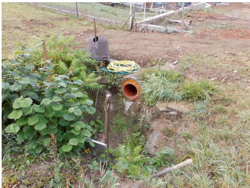
**Abbildung: Flutgraben Nauweg, Einlauf in Verrohrung im Geländetiefpunkt**
