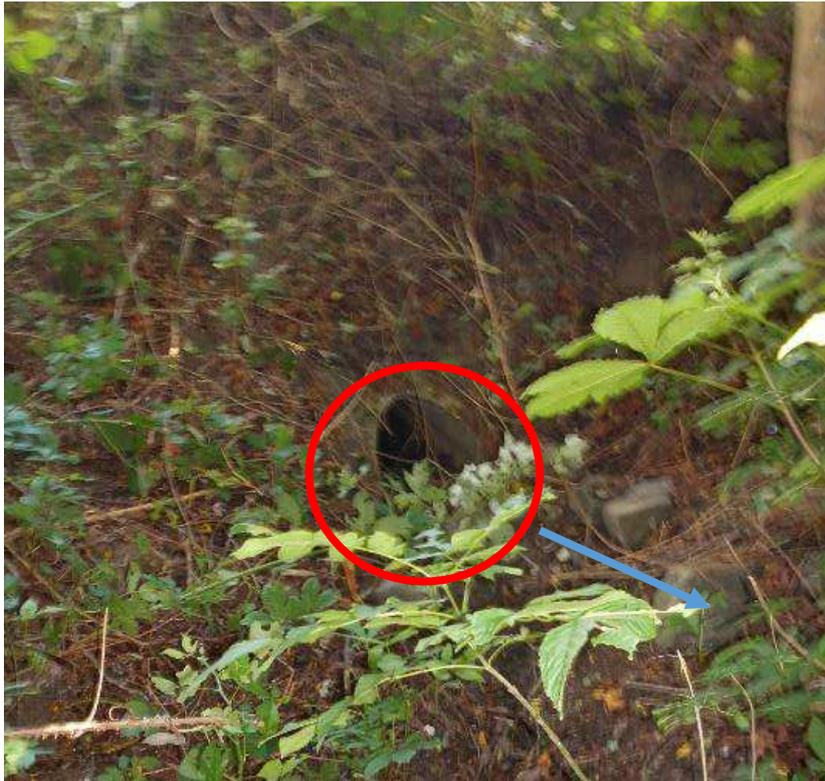
**Abbildung: Auslauf Straßendurchlass (DN 400 SB) zum Löschweiher**
