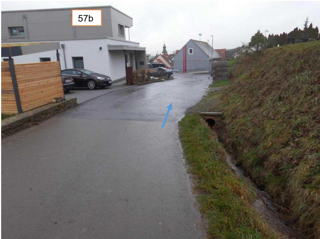
**Abbildung: Blick auf Anwesen Nr. 57b / Ungeschützter Rohreinlauf**
