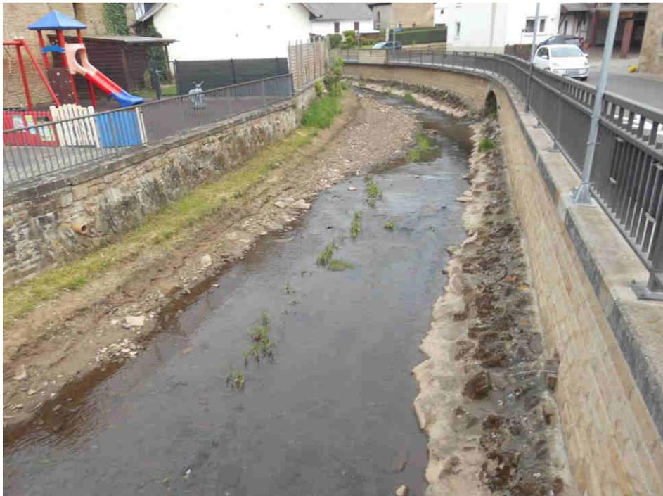
**Abbildung: Mauer zur L 182 / Prallufer Jeckenbach – Ausgebaggertes Gewässerprofil
