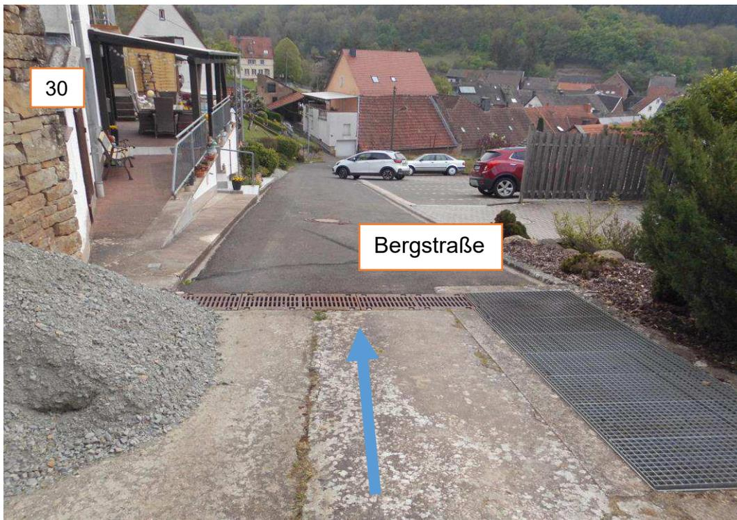
**Abbildung: Blick auf die „Bergstraße“ mit Querrinne und Einlaufbauwerk (in Fließrichtung)**
