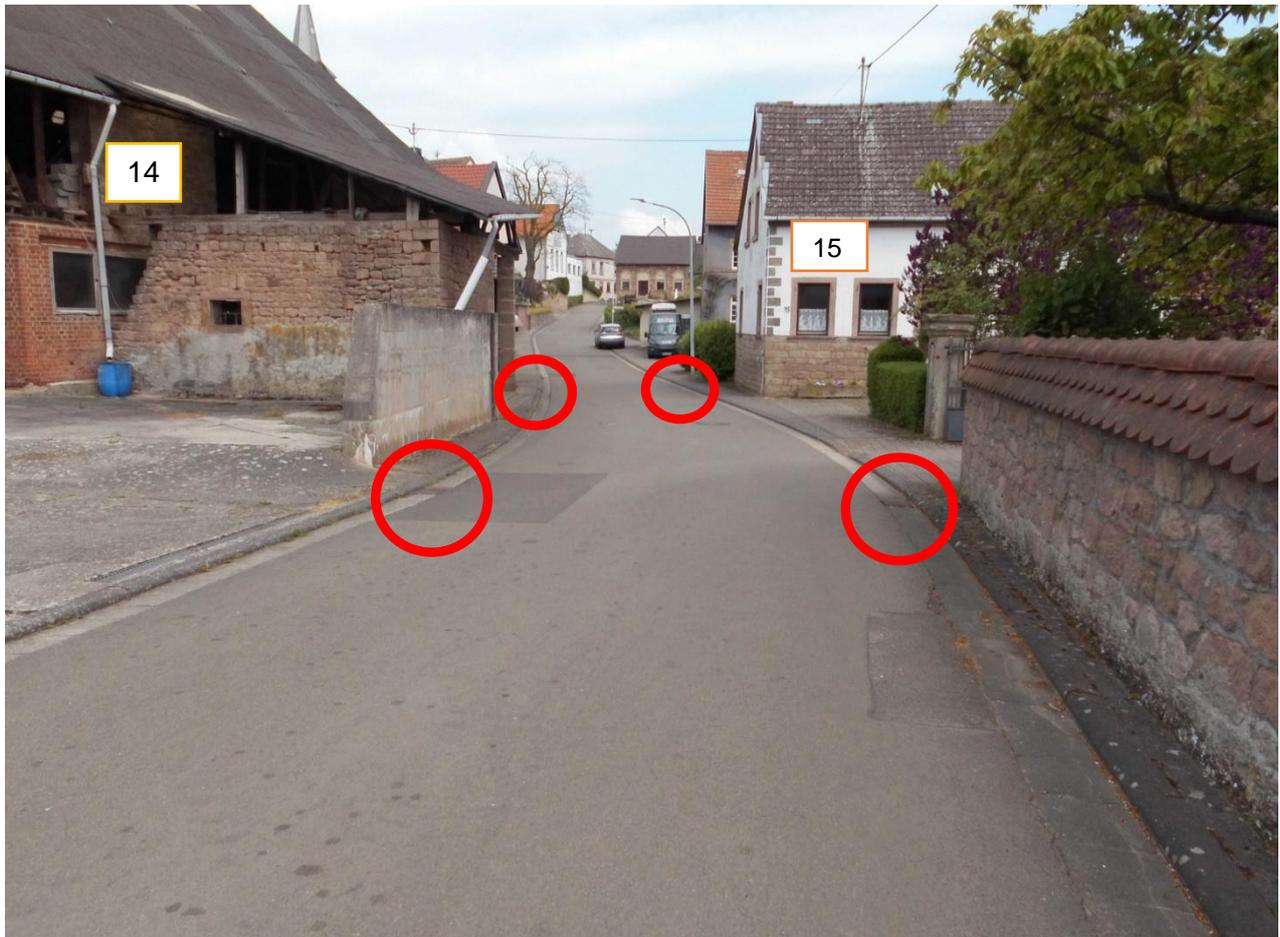
**Abbildung: Senke in der Untergasse mit Straßeneinläufen**
