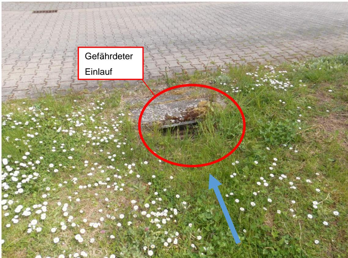
**Abbildung: Blick auf Einlaufbauwerk / Gefährdung der Verkläuserung**
