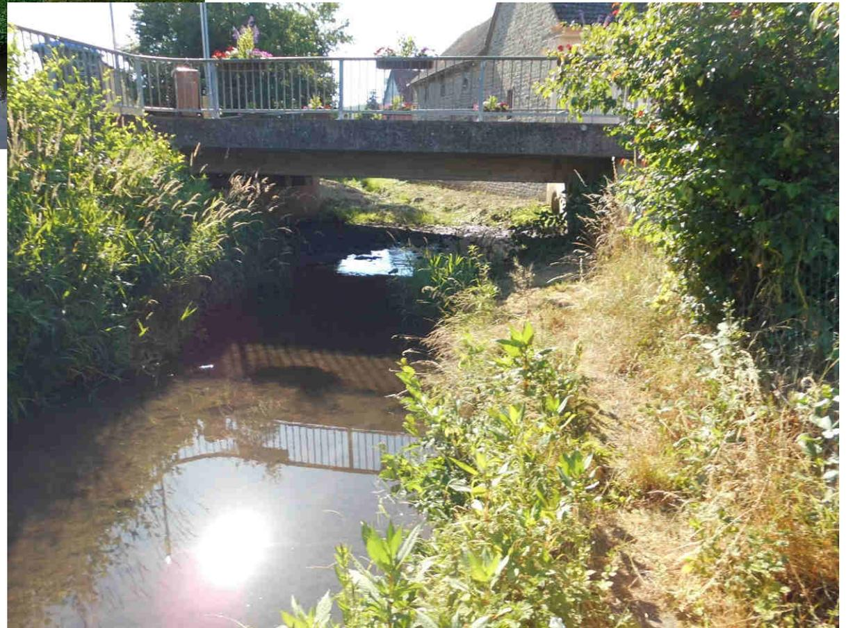
Zum Teil wird das Abflussprofil durch starken Bewuchs verengt.
