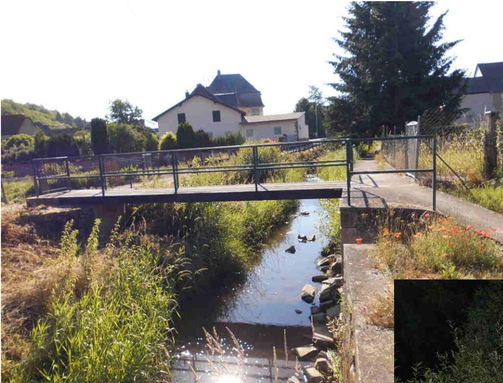
Die Überflutungen der Gärten oberhalb der Brücke L 182 werden durch hydraulische Engpässe (Steg über den Jeckenbach, Übergang von natürlichem Abflussprofil in das mit Mauern gefasste Profil) verursacht.
