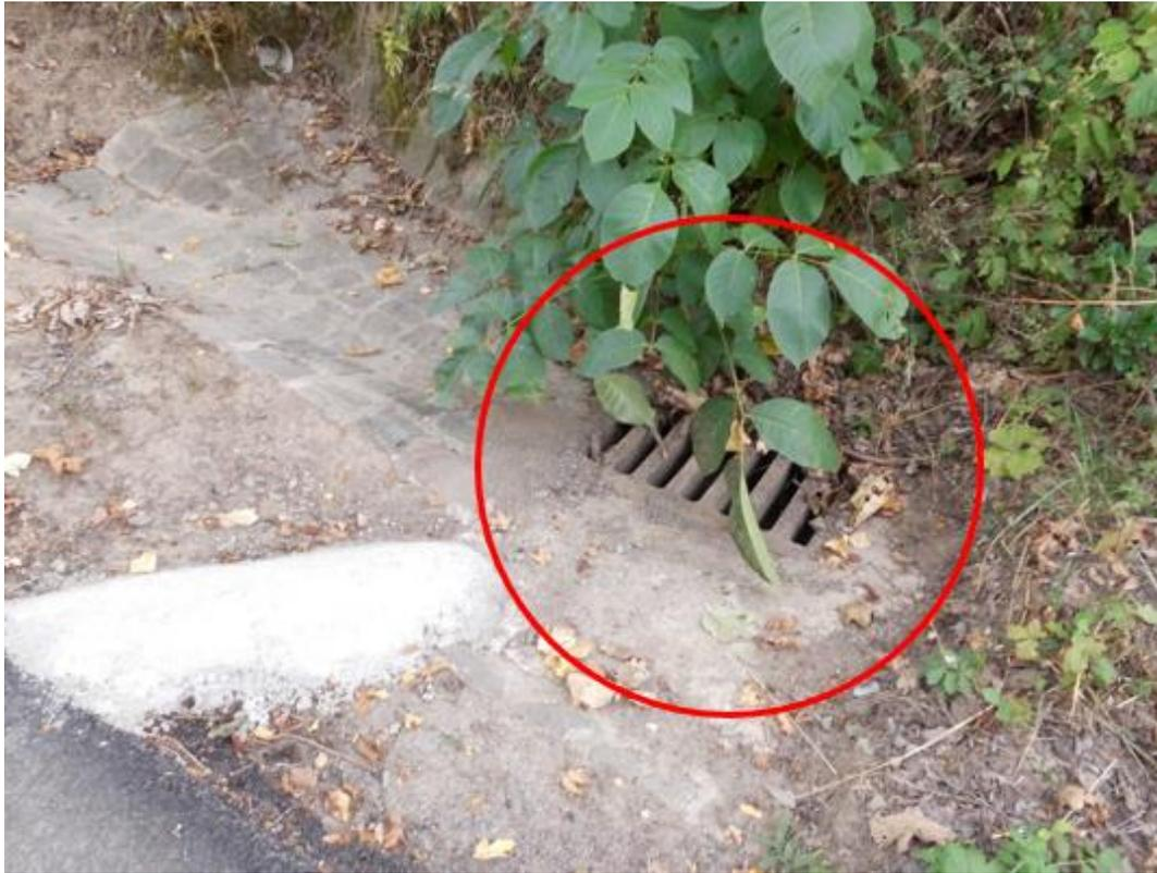
**Abbildung: Grabenentwässerung/ Straßeneinlauf**
