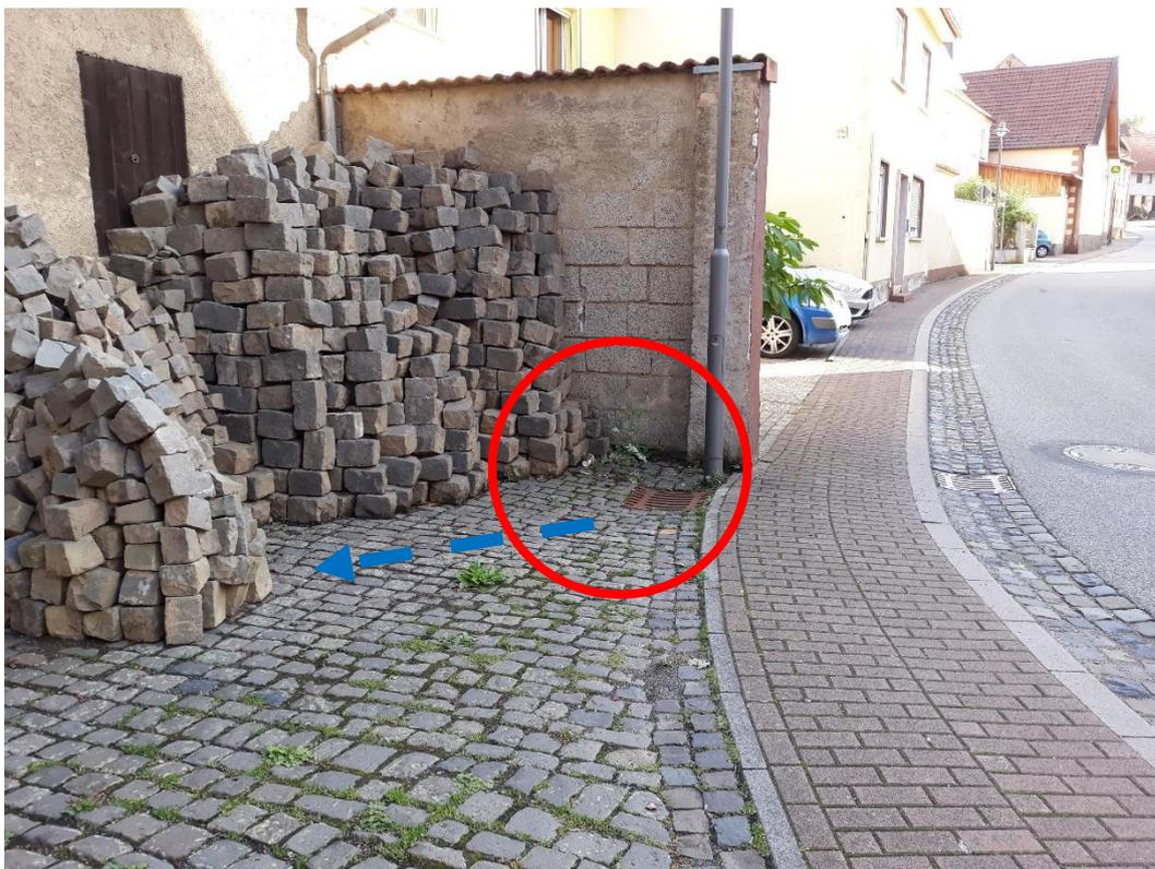
Abbildung: Hauptstraße / L 376 Tiefpunkt, Einlauf zum Regenwasserkanal DN 500 (Abtweiler Bach)
